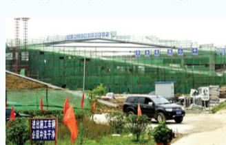
日前,位于滨湖塘西河入湖口东侧的巢湖藻水分离港,地上2层主体厂房已完工。分离港采用先进的机械方式治理蓝藻,日处理藻水达3360吨,是目前国内日处理能力最大的藻水分离港。记者 倪路/图
