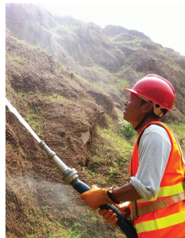
李文华正在给山坡喷水,做复绿工程
