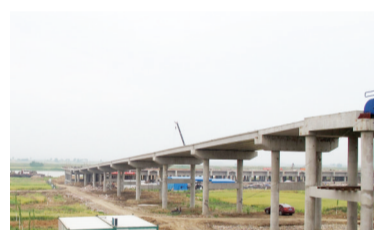
建设中的煤化工基地码头
