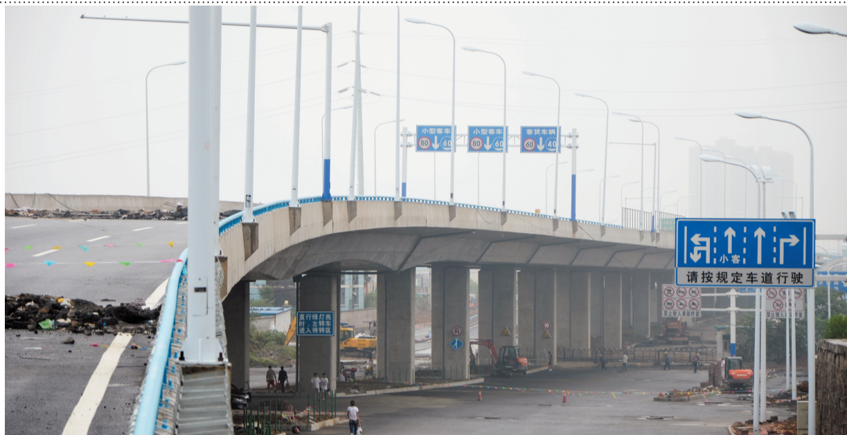
阜阳路高架桥上桥下主体已经完工，等待放行
