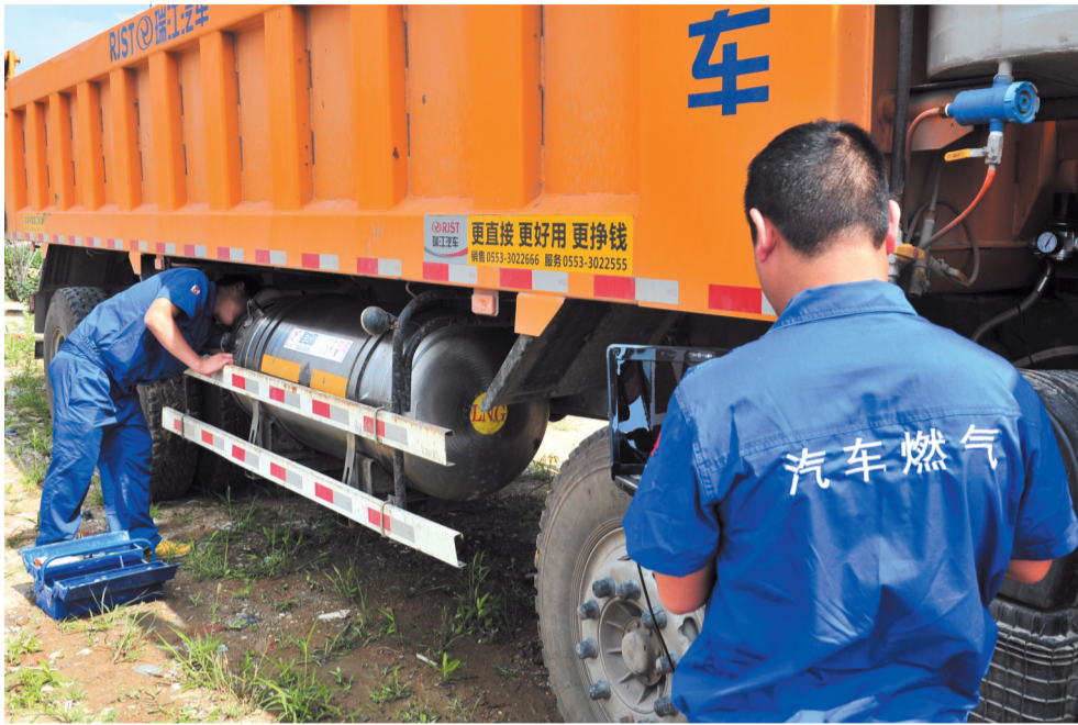
工人在为大货车安装LNG气罐
