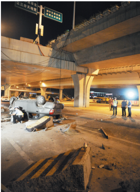
被撞掉的混凝土挡墙
