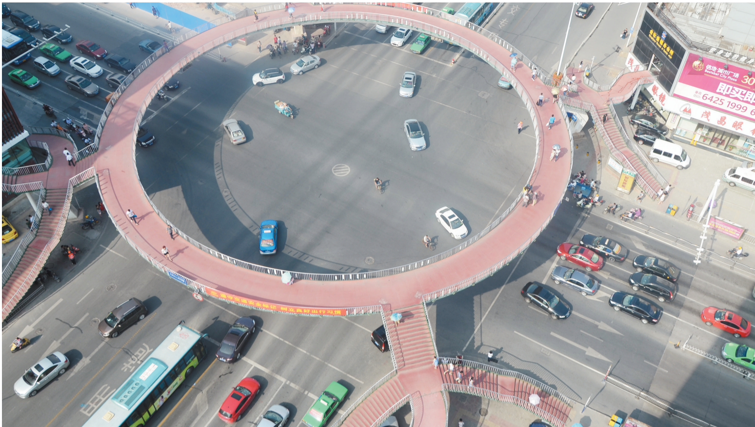
6月下旬将局部拆除的三孝口天桥
