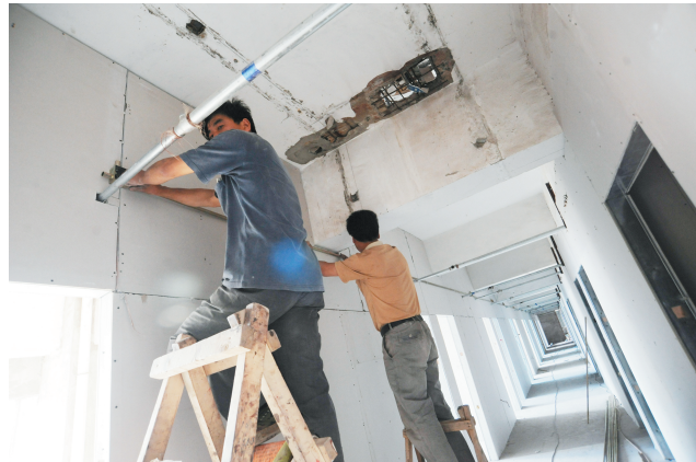
工人们正在加紧装修 争取早日完工
