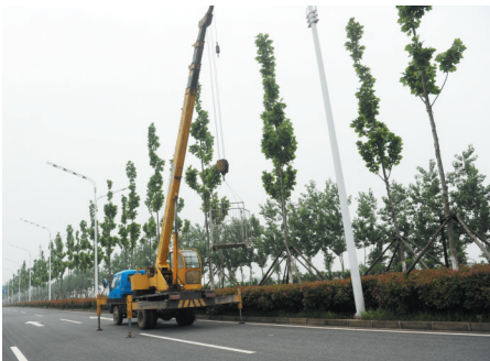
机场高速沿途的绿化已经完成 路灯设施也在做最后的调试
