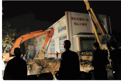
供水员工夜以继日忙施工保供水献“贴心”
