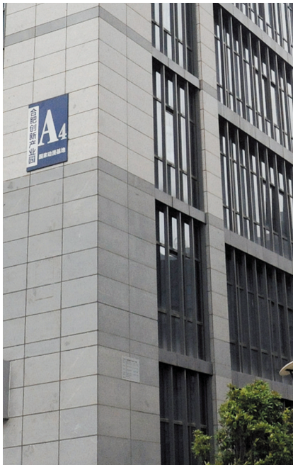
“创新产业园”牌子已在墙上
