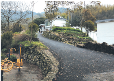
新修的柏油路贯通全村
