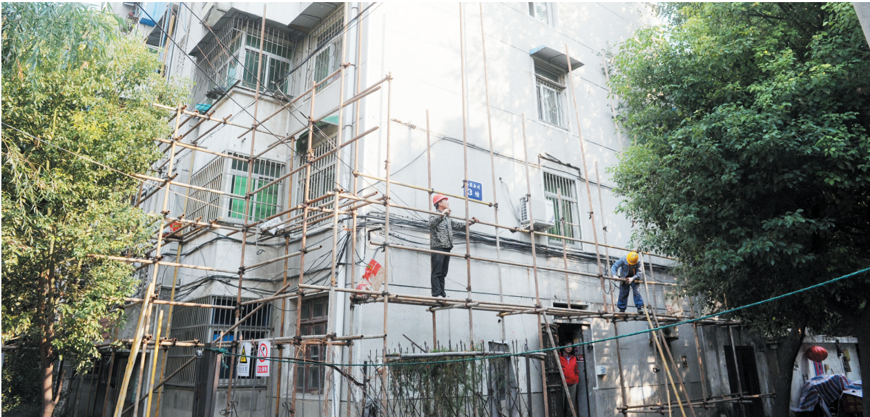
畅园新村老旧小区改造现场
