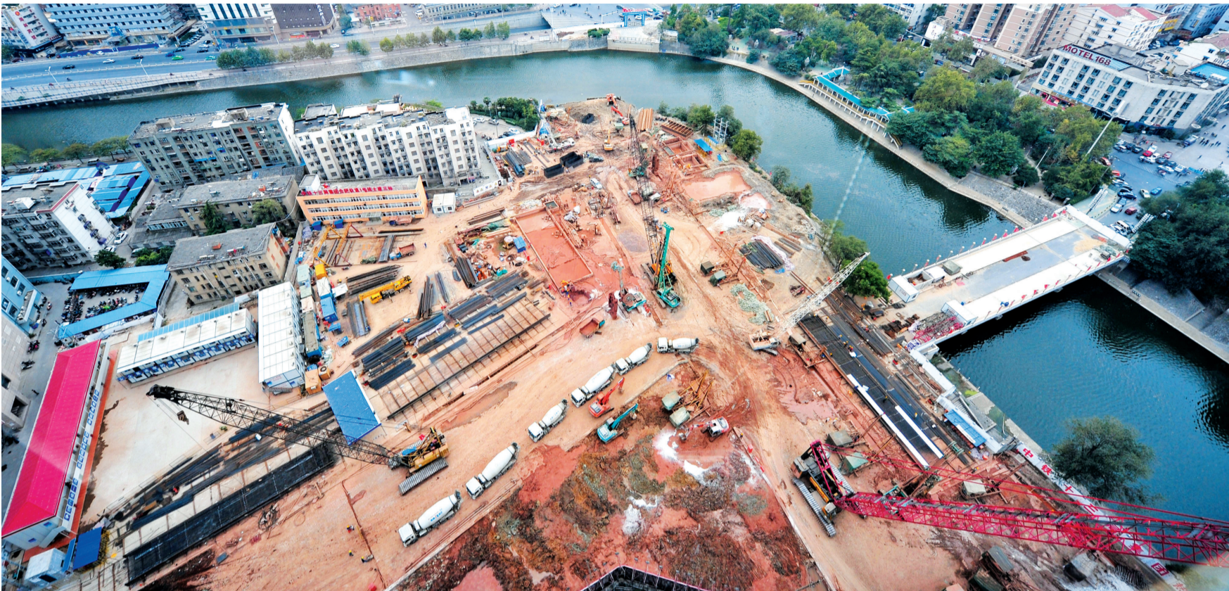
一号线大东门施工现场
