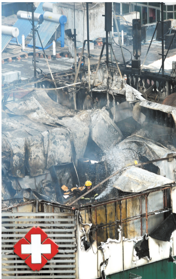
消防人员正在楼顶灭火
