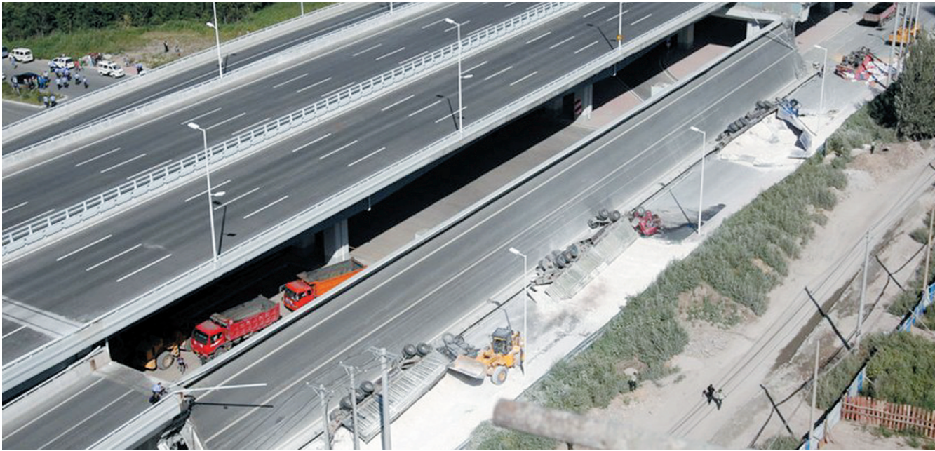
大桥垮塌现场
