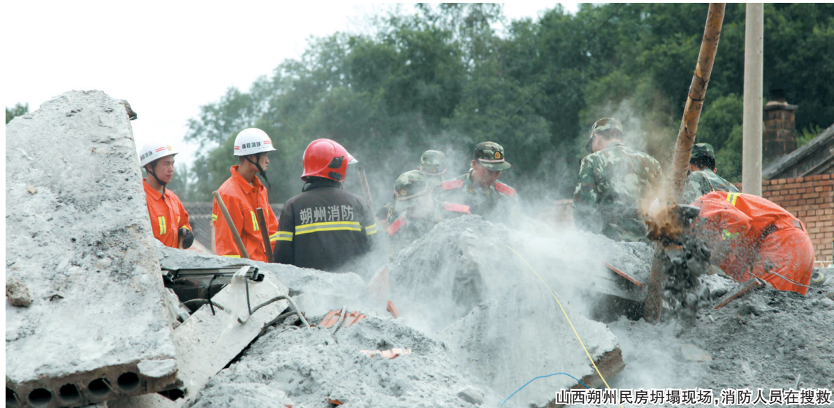
山西朔州民房坍塌现场,消防人员在搜救
