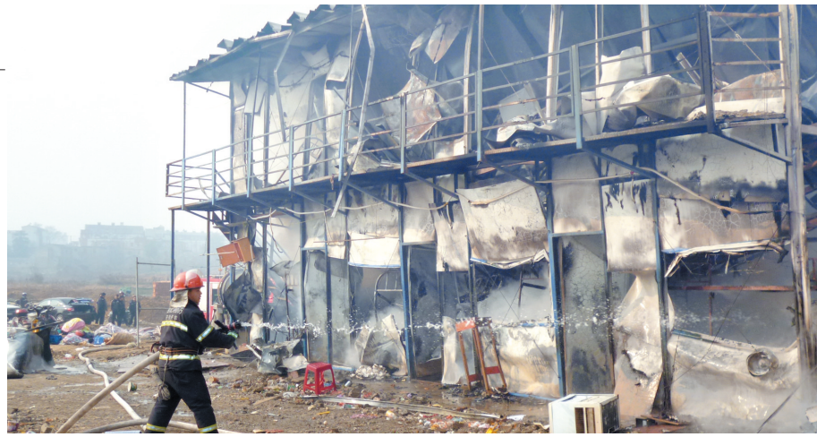
火灾现场, 消防人员正在紧张地扑灭大火
