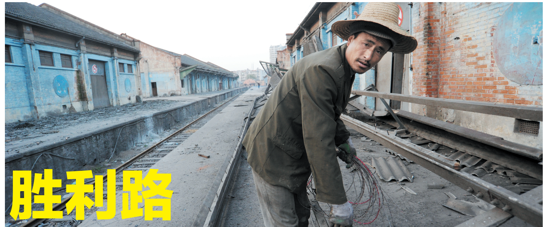
工人在拆除南站铁轨
