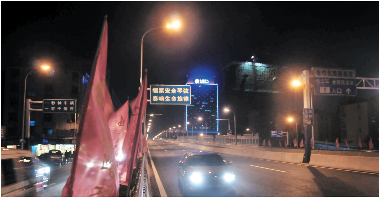
近日,合肥市合作化路高架桥施工已进入最后阶段,该高架桥很快将实现桥上、桥下的“双贯通”。昨日记者路过合作化路北端下桥口时注意到,南北向桥面已经有部分车辆驶过,提前感受高架带来的便捷,而由北向南方向的桥面暂时无法通行。 记者 黄洋洋/图
