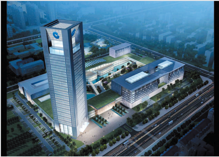
中国建设银行合肥生产基地及安徽省分行综合业务楼
