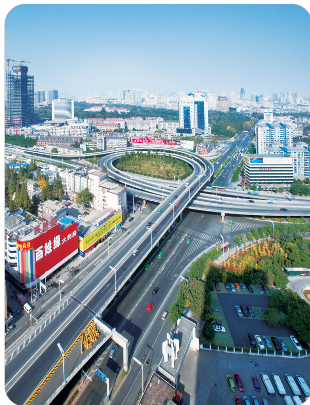
合肥金寨路高架桥获国家优质工程银奖
