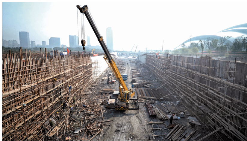
畅通二环工程怀宁路下穿施工现场
