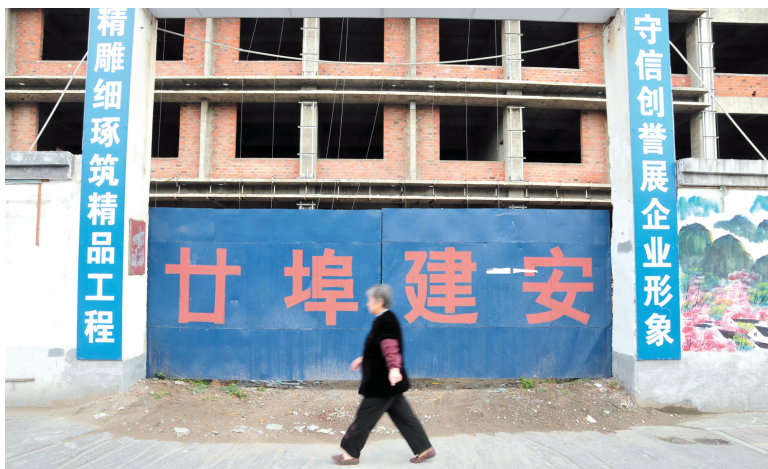
工地仍然处于停工状态
