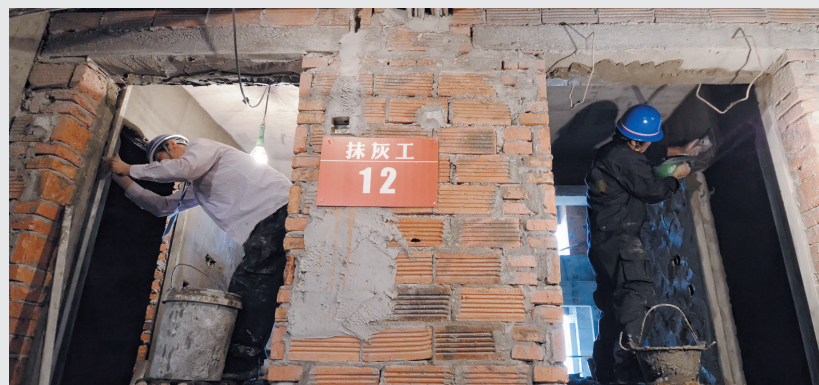
抹灰工用工具测量墙面是否平整
