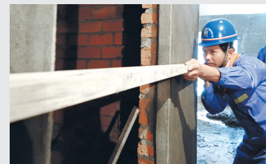
砌筑工在仔细测量墙面是否垂直
