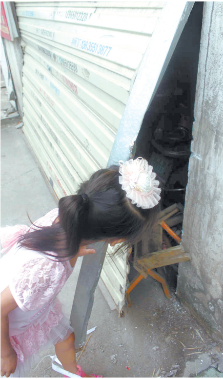
一间门面房的卷闸门被撬开关不上
