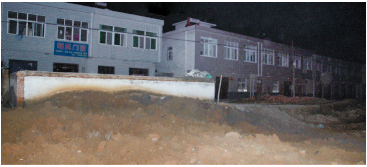
塌方的土坑已被黄土填平
