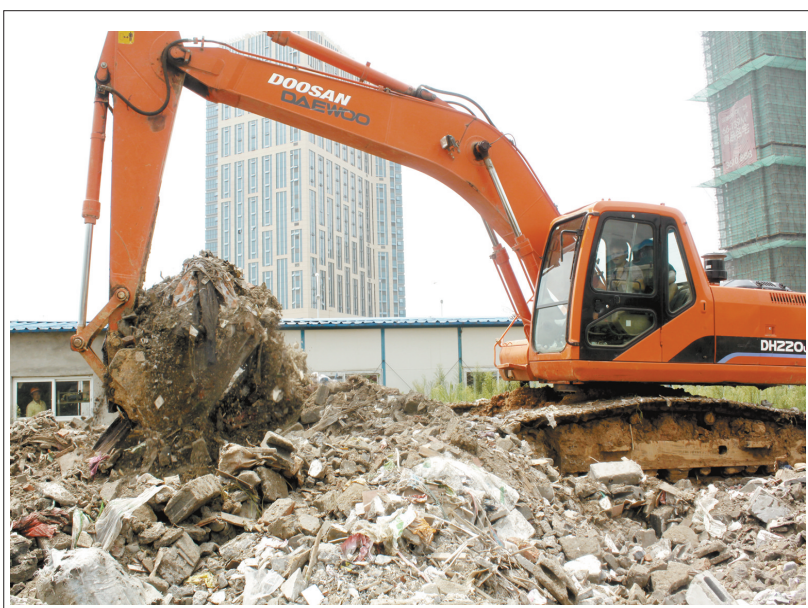
8月12日上午,合肥蜀山区城管执法大队组织人员对金东路附近堆积的建筑垃圾进行清理,共清理垃圾近百吨。实习生 李睿 记者 范竹标 文/图
