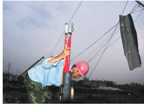
工人正在抢修电路
