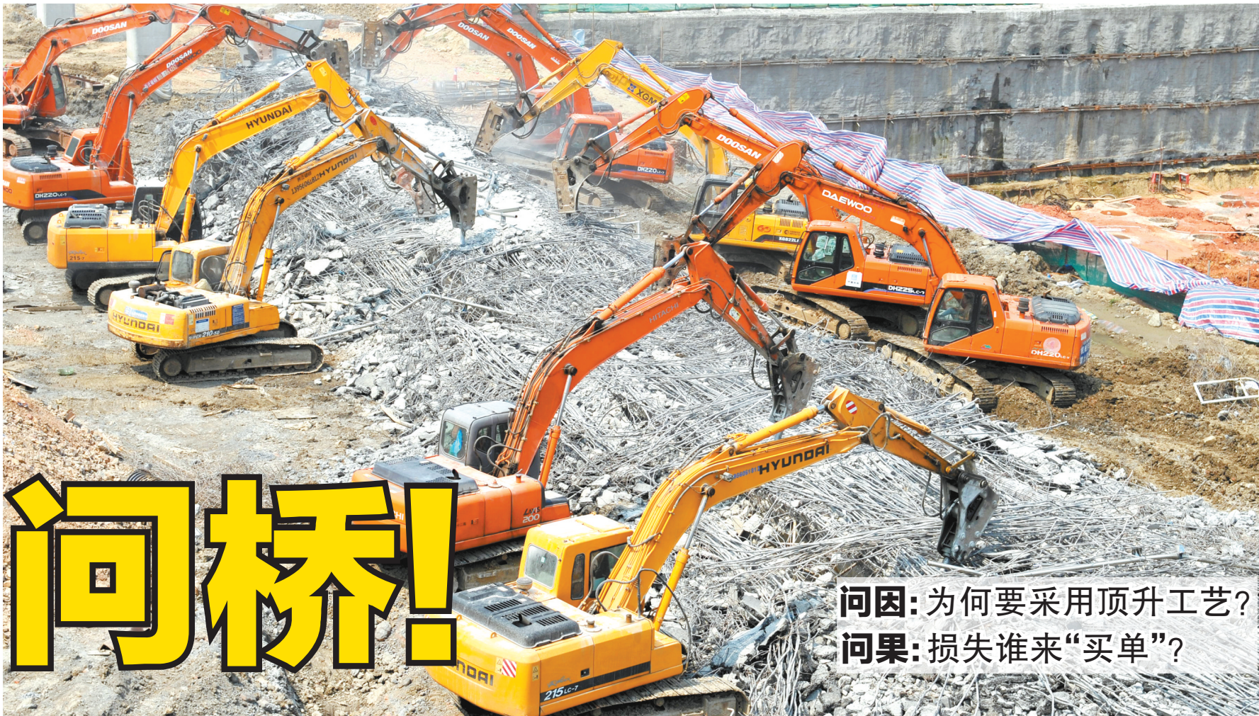
十多台挖掘机在对垮塌桥面进行破拆
