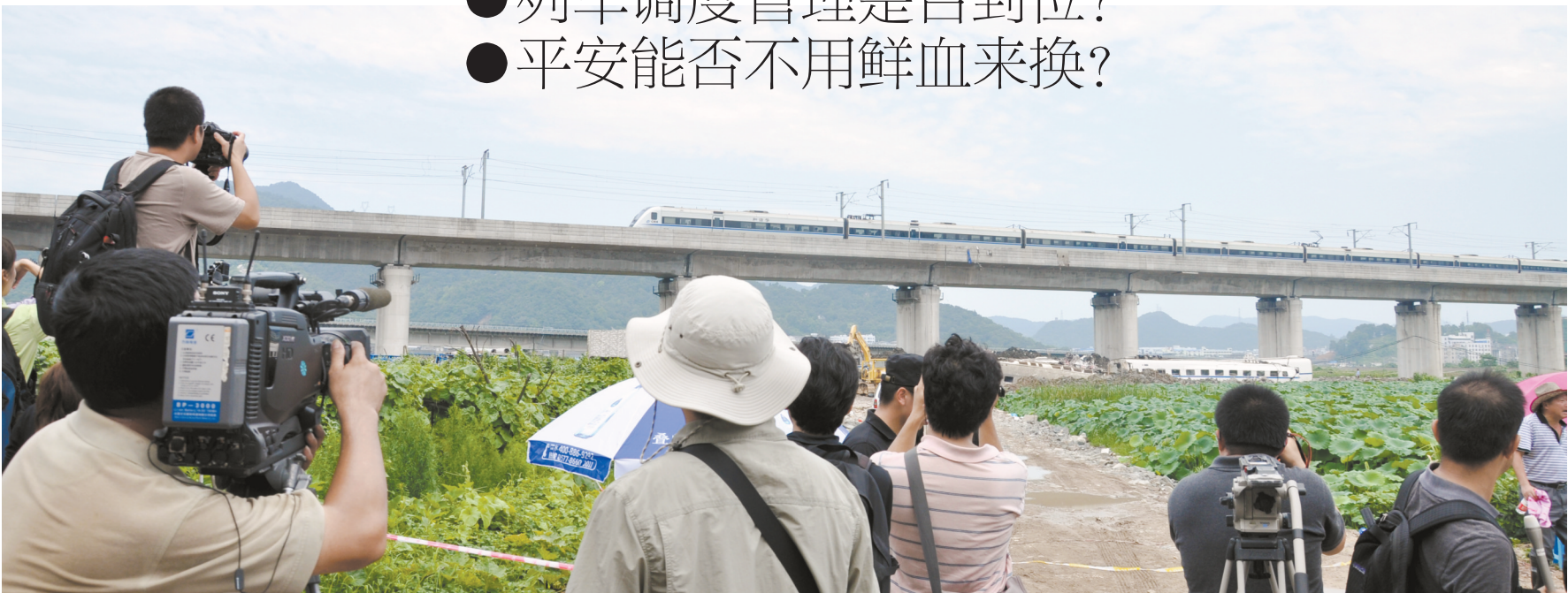
7月25日,一列列车驶过事故路段。从上海铁路局杭州站获悉,经过一天的紧急抢修,动车追尾坠桥事故路段已清理干净,甬温线已恢复动车开行条件。
