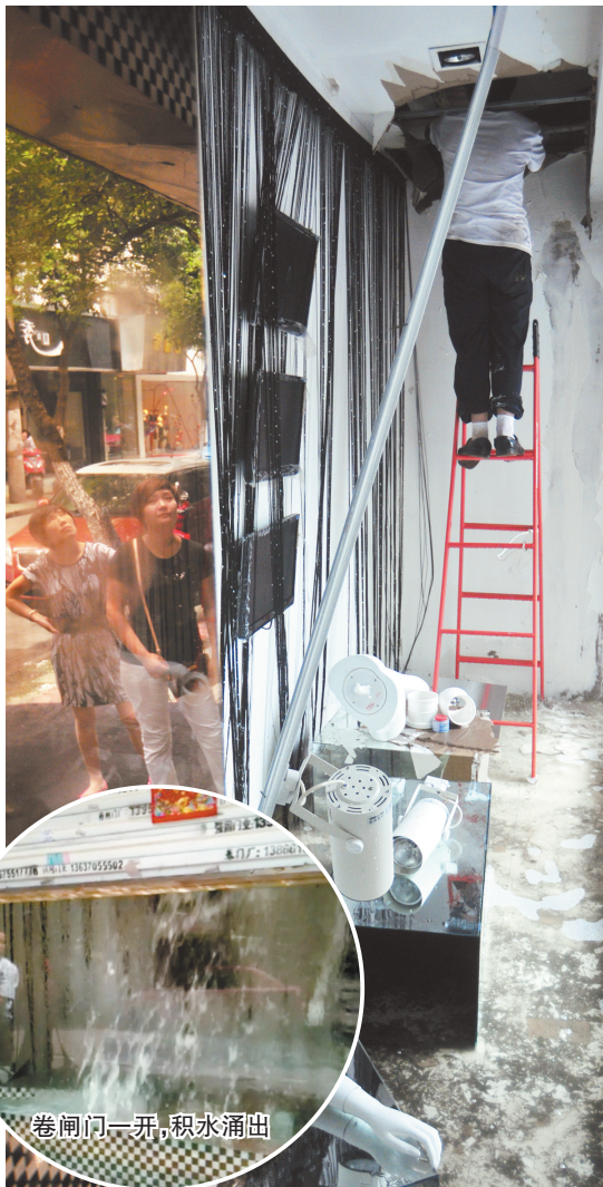
师傅维修天花板内破裂的水管
