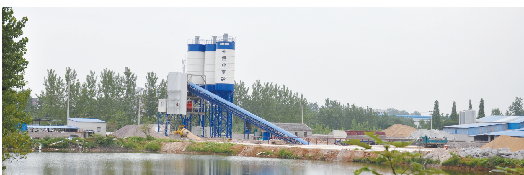
建在淠河干渠堤上的“恒业混凝土搅拌站”
