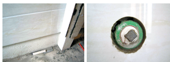
图: 墙压地工艺及瓷砖切割
