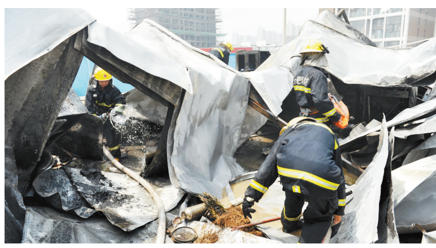
昨天上午10时25分左右,位于合肥市怀宁路和黄山路交口处的一在建工地工棚着火,浓烟冒出十多米高,大火造成该工棚3间约50平米的板房坍塌,所幸没有造成人员伤亡。据了解,被烧毁板房在二楼,楼下为该工地食堂。据该工地物业公司的刘姓负责人介绍,大火是从工棚西侧房间烧起的,可能由二楼办公室挂式空调电路老化引起。然而,据该处一保安称,起火的原因是一楼食堂用火不当引起的。 见习记者 丁林/文 李超钰/图
