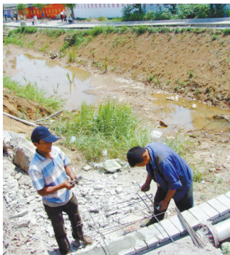
含山县姚庙村村民在抢修水利设施
