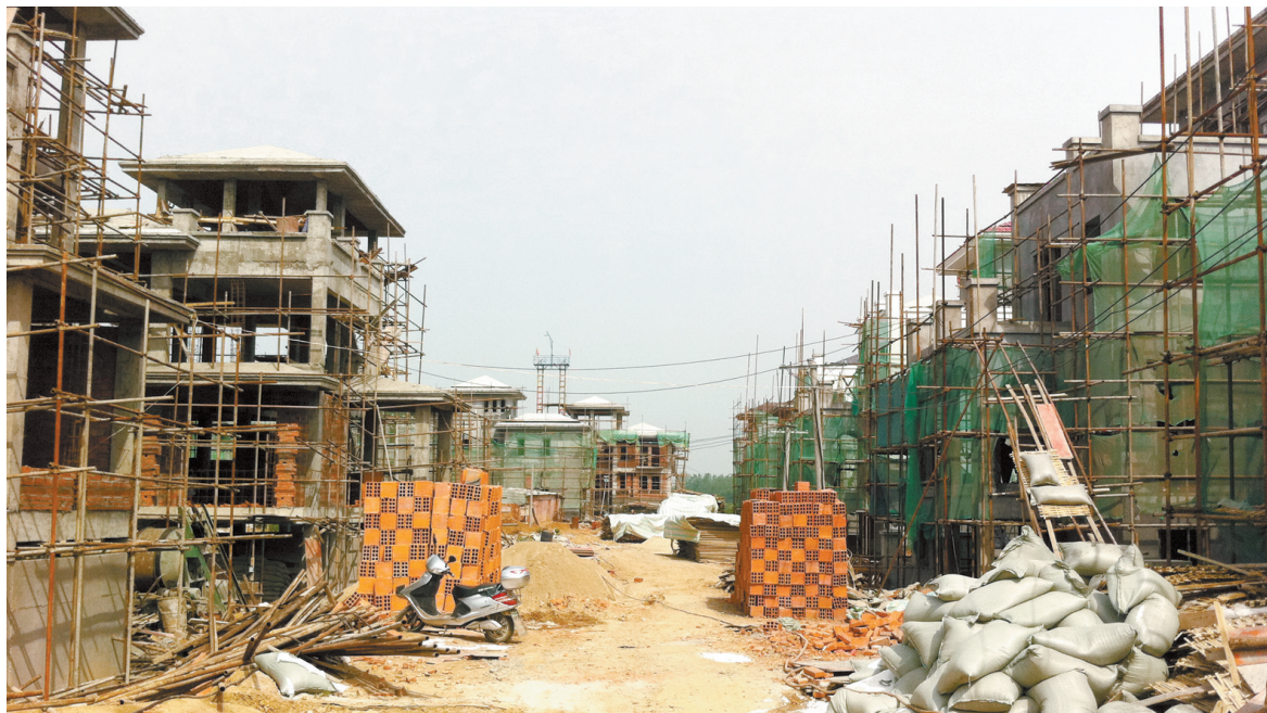
正在建设中的别墅群
