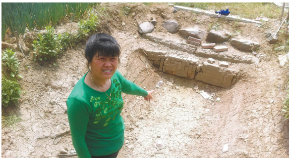
菜地旁的蓄水池干涸开裂
