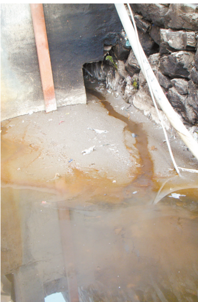
化工厂污水随意排放
