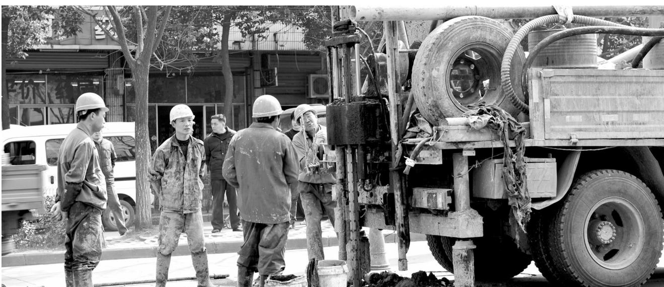
日前,合肥阜阳北路高架正式启动,数台钻机已进入施工现场,开始进行前期的钻探工作。据了解,阜阳北路高架全长将达到9.1公里,建成后又将形成又一条南北向的快速通道,也将成为合肥最长的一座高架桥。 倪路文/图
