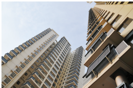
省质监局景治园小区分体式太阳能一体化工程
