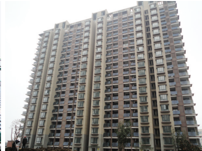
庐阳馨苑分体式太阳能一体化工程
