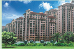
一期实景照片
