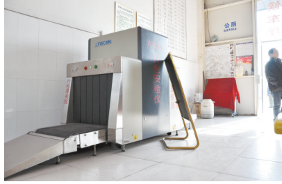
安检机器没有开启,沦为摆设
