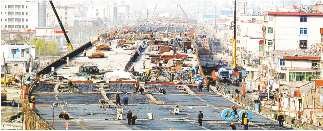
省城一高架桥建设现场
