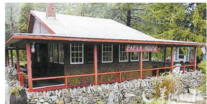
大约90年前,一位叫做尔里斯·斯迪曼的发明家、工程师在美国马萨诸塞州的石港市,就开始用收集来的旧报纸盖了一间房子。时至今日,他的报纸房子成了当地一个旅游景点。据介绍,报纸房子的骨架跟其他房子一样,也是用木头做的,它也有木质的地板和房顶。墙壁则是用有着良好隔热功能的、大约1英寸厚的压缩纸张做成。星报综合
